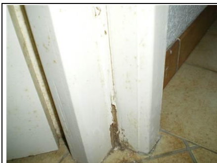
Photo n° PhTer001 Localisation : Dégagement Ouvrage : Sol - Carrelage Mur - Enduit et Peinture Plafond - Plâtre et Peinture Plinthes - Carrelage Parasite : Présence d'indices d'infestation de termites Indices : altérations dans le bois Localisation sur croquis : 001
