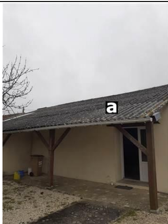
PHOTO N° PHA001 LOCALISATION : GARAGE; GARAGE 2 OUVRAGE : PLAQUES ONDULÉES PARTIE D'OUVRAGE : PLAQUES EN FIBRES-CIMENT DESCRIPTION : PLAQUES EN FIBRES-CIMENT
