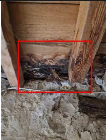
Photo n° PhTer002 Localisation : grenier Ouvrage : poutre bois Parasite : --- Champignons lignivores --- Indices : dégradation du bois (élément(s) fortement dégradé(s))
