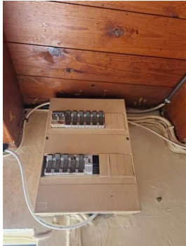
installation électrique vétuste
