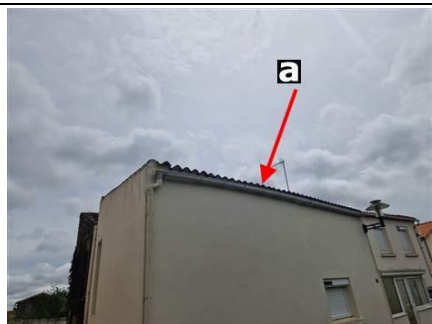
Photo n° PhA001 Localisation : TOITURE CUISINE/CH1 Ouvrage : Plaques ondulées Partie d'ouvrage : Plaques en fibres-ciment Description : Plaques en fibres-ciment
