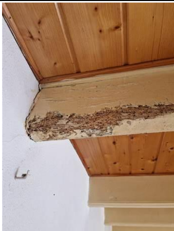
Photo n° PhTer001 Localisation : Séjour Ouvrage : Poutre bois Parasite : ---- Insectes à larves xylophages ----, Anobium punctatum (Petites vrillettes) Indices : altérations dans le bois (élément(s) dégradé(s))
