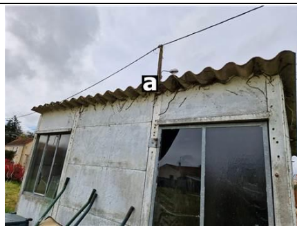
Photo n° PhA001 Localisation : cabanon Ouvrage : Plaques ondulées Partie d'ouvrage : Plaques en fibres-ciment Description : Plaques en fibres-ciment
