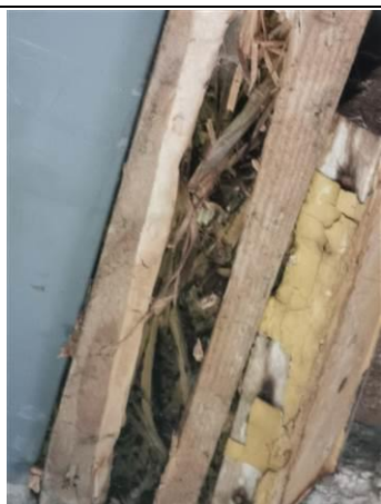
Photo n° PhTer001 Localisation : Garage 2 Ouvrage : Poutres Parasite : Présence d'indices d'infestation de termites Indices : altérations dans le bois, bois d'apparence feuilleté (dégradation(s) importante(s))
