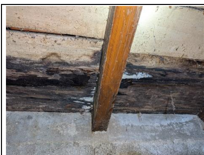
Photo n° PhTer001 Localisation : Bâtiment (s) Annexe (s) - Débarras Ouvrage : Plafond - Charpente : Pannes, Chevrons, Volige : Bois Parasite : --- Champignons lignivores ---
