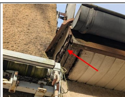
Photo n° PhTer002 Localisation : Parties extérieures Ouvrage : Habillage chaineau en bois
