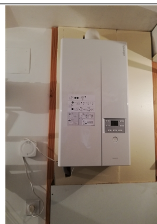
Photo n° PhGaz001 Localisation : 2ème étage - Rangement Chaudière SAUNIER DUVAL (Type : Etanche)
