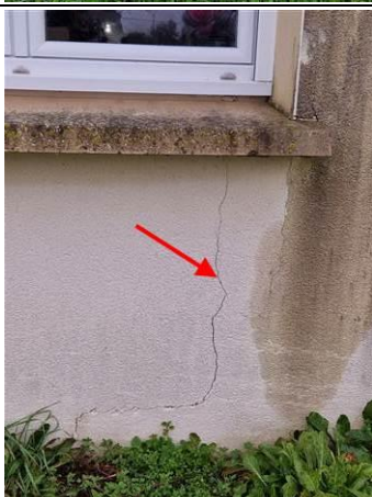
Photo n° PhTer003 Localisation : Enduit murs extérieur Ouvrage : Murs EST.SUD.OUEST Informations complémentaires : Présence de fissures sur murs et enduits extérieur
