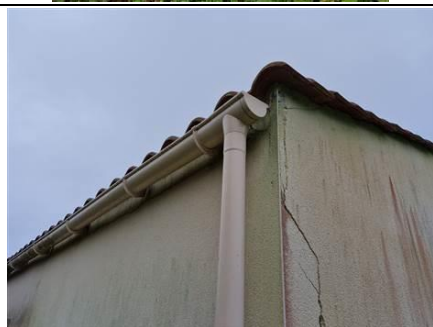
Photo n° PhTer003 Localisation : Enduit murs extérieur Ouvrage : Murs EST.SUD.OUEST Informations complémentaires : Présence de fissures sur murs et enduits extérieur
