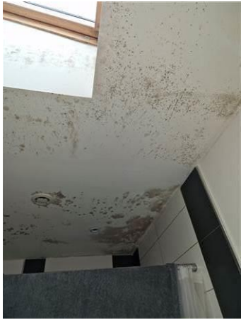
Photo n° PhTer002 Localisation : SDE Ouvrage : plafond Parasite : Moisissures Informations complémentaires : probleme d'humidité SDE
