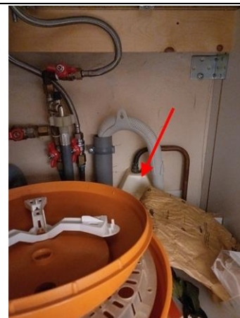
Photo n° PhGaz003 8a2 : au moins un organe de coupure d'appareil n'est pas accessible. (Rez de chaussée - Cuisine) Placé au fond du placard
