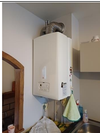
Photo n° PhGaz002 Localisation : Rez de chaussée - Cuisine Chaudière SAUNIER DUVAL (Type : Raccordé)
