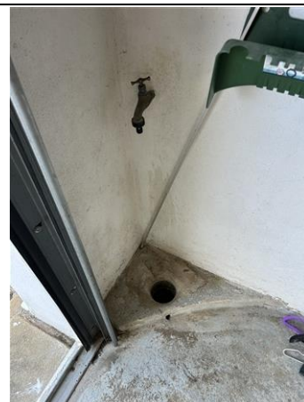
Photo n° PhAss003 Localisation : Eau Usée : Garage Description : Siphon de sol : Rejet dans grille descente garage puis rejet avec la pompe de relevage en épandage
