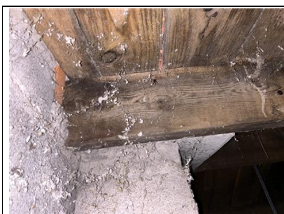
Photo n° PhTer002 Localisation : Combles - Combles Accès Escalier Ouvrage : Plafond - Charpente : Pannes, Volige : Bois Parasite : --- Champignons lignivores ---
