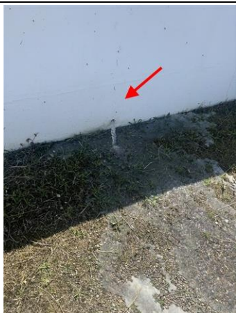
Photo n° PhAss004 Localisation : Eau Pluviales : Extérieur Description : Descente de garage (Grille) : Rejet avec la pompe de relevage en épandage
