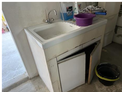
Photo n° PhAss002 Localisation : Eau Usée : Buanderie Description : Evier : Rejet dans grille descente garage puis rejet avec la pompe de relevage en épandage
