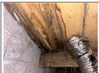
Photo n° PhTer001 Localisation : Combles - Combles Accès Salle à manger Ouvrage : Plafond - Charpente : Pannes, Volige : Bois Parasite : --- Champignons lignivores ---
