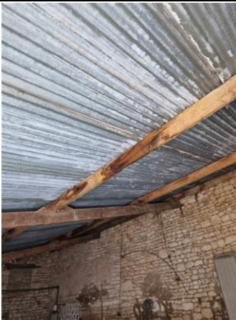
Photo n° PhTer001 Localisation : Garage Ouvrage : bois Parasite : --- Champignons lignivores --- Indices : dégradation du bois (élément(s) faiblement dégradé(s))
