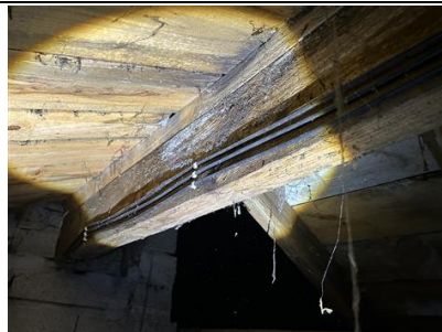
Photo n° PhTer002 Localisation : Combles - Combles Ouvrage : Plafond - Charpente: Entrails, Arbalétriers, Poinçons, Contrefiches, Pannes, Chevrons, Volige : Bois Parasite : ---- Insectes à larves xylophages ----, --- Champignons lignivores ---
