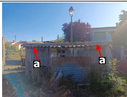
Photo n° PhA001 Localisation : abri de jardin et stockage Ouvrage : Plaques ondulées Partie d'ouvrage : Plaques en fibres-ciment Description : Plaques en fibres-ciment
