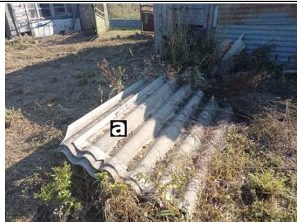
Photo n° PhA001 Localisation : abri de jardin et stockage Ouvrage : Plaques ondulées Partie d'ouvrage : Plaques en fibres-ciment Description : Plaques en fibres-ciment
