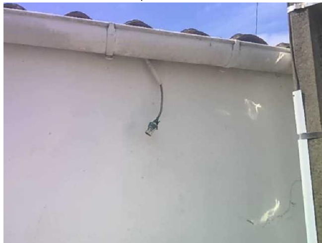
B.7.3 d) : L'installation électrique comporte au moins une connexion avec une partie active nue sous tension accessible.
