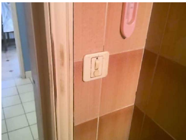
B.8.3 a) : L'installation comporte au moins un matériel électrique vétuste.
