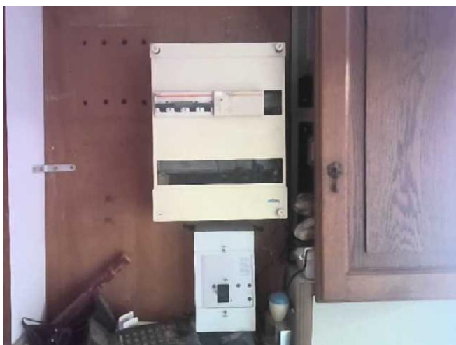
B.2.3.1 a) : Il n'existe aucun dispositif différentiel.
