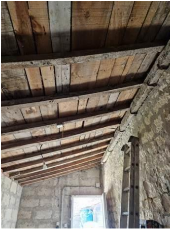
Photo n° PhTer001 Localisation : Garage Ouvrage : bois Parasite : ---- Insectes à larves xylophages ----, Anobium punctatum (Petites vrillettes) Indices : altérations dans le bois (dégradation(s) faible(s))
