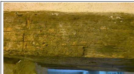
Photo n° Ph004 Localisation : Cuisine Ouvrage : Sol - Carrelage Mur - Peinture, pierre, enduit Plafond - Peint Fenêtre(s) en PVC Porte(s) en PVC Parasite : Présence d'indices d'infestation d'autres agents de dégradation biologique du bois Indices : altérations dans le bois
