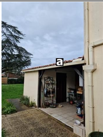
Photo n° PhA001 Localisation : Appenti Ouvrage : Plaques ondulées Partie d'ouvrage : Plaques en fibres-ciment Description : Plaques en fibres-ciment
