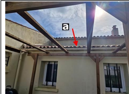
Photo n° PhA001 Localisation : cellier; sde travaux Ouvrage : Plaque ondulée Partie d'ouvrage : Plaque en fibres-ciment Description : Plaque en fibres-ciment
