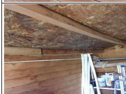
Photo n° Ph001 Localisation : Dépendances - Abris de jardin Ouvrage : Sol - Bois Mur - Bois Plafond - Bois, charpente bois Porte(s) en bois Parasite : Présence d'indices d'infestation d'autres agents de dégradation biologique du bois
