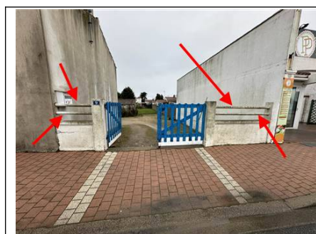
Photo n° Ph002 Localisation : Parties extérieures Ouvrage : Murs, Cloisons "en dur" et Poteaux (périphériques et intérieurs) Partie d'ouvrage : Entourages de poteaux (amiante-ciment) Description : Entourages de poteaux (amiante-ciment) Localisation sur croquis : Point 001
