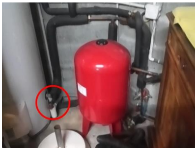
Photo n° PhAss004 Localisation : Eau Usée : Garage Description : Ballon d'eau chaude : Rejet non retrouvé
