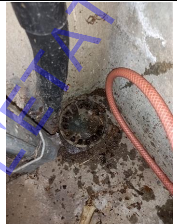
Photo n° PhAss003 Localisation : Eau Usée : Garage Description : Bonde de sol : Rejet dans les eaux pluviales
