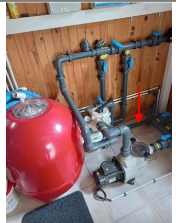
Photo n° PhAss006 Localisation : Eau Usée : Local technique Description : piscine (nettoyage filtre) : Rejet dans les eaux pluviales
