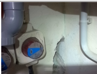
Photo n° PhGaz001 Localisation : Cellier Robinet en attente (Type : Non raccordé)
