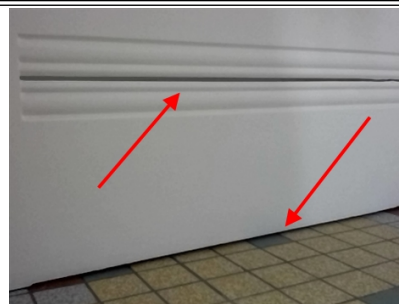
Photo n° PhGaz006 19.2 : la section de l'amenée d'air du local équipé ou prévu pour un appareil d'utilisation est manifestement insuffisante (section d'orifice ou nombre de modules). (Cuisine) Amenée d'air manifestement insuffisante; Agrandir le passage d'amenée d'air sous la porte
