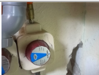
Photo n° PhGaz002 8b : l'extrémité de l'organe de coupure d'appareil ou de la tuyauterie en attente n'est pas obturée. (Cellier) L'extrémité du robinet en attente n'est pas obturée; Poser ou faire poser un bouchon par un installateur gaz qualifié sur l'extrémité du robinet
