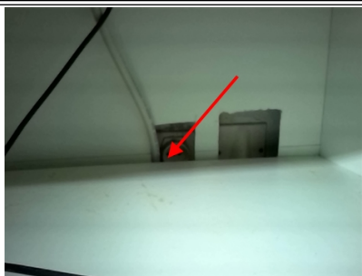
Photo n° PhGaz004 15a : le tuyau flexible d'alimentation en gaz passe dans une zone dangereuse. (Cuisine) Le tuyau non rigide passe dans une zone dangereuse; Faire intervenir un installateur gaz qualifié afin de déplacer ou protéger le tuyau non rigide
