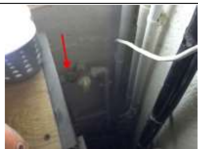
Photo n° PhGaz002 8b : l'extrémité de l'organe de coupure d'appareil ou de la tuyauterie en attente n'est pas obturée. (Rez de chaussée - Garage) Absence de bouchon
