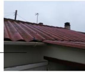
ZPSO-002 - Plaques en fibres-ciment (y compris plaques « sous tuiles »)
