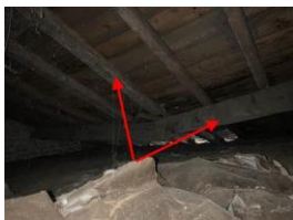
Parasites du bois dans la charpente
