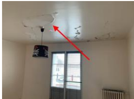
Présence d'humidité sur le plafond de plusieurs pièces
