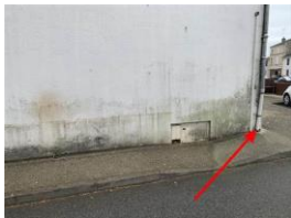
Eaux pluviales mal raccordées
