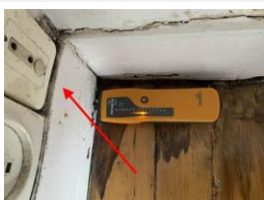
Fuite d'eau dans la salle de bain / Présence de pourriture cubique et d'un taux d'humidité supérieur à 20%
