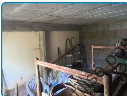
Maison principale Rez de chaussée Pièce sous toit terrasse
