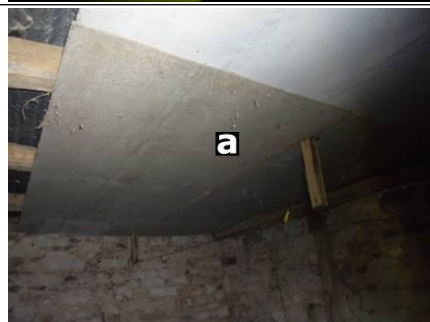
Photo n° Ph002 Localisation : RDC - Garage Ouvrage : 4. Eléments intérieurs- plafond Partie d'ouvrage : Plaques (fibres-ciment) Description : Plaques (fibres-ciment)
