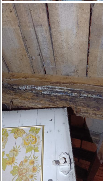
Photo n° PhTer002 Localisation : Grenier Ouvrage : bois Parasite : --- Champignons lignivores --- Indices : décoloration du bois, dégradation du bois (dégradation(s) importante(s))
