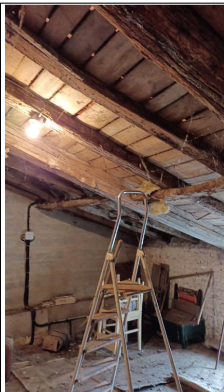
Photo n° PhTer001 Localisation : Grenier; Combles Ouvrage : charpente bois Parasite : ---- Insectes à larves xylophages ----, Anobium punctatum (Petites vrillettes) Indices : altérations dans le bois
