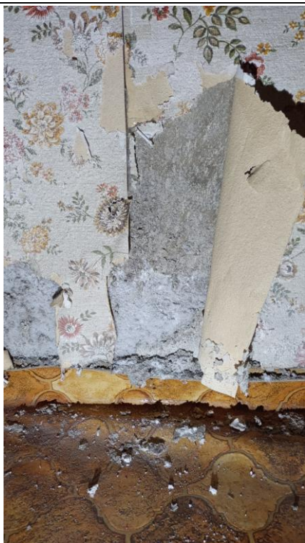
Photo n° PhA003 Localisation : Séjour; Salon Ouvrage : Murs et cloisons Partie d'ouvrage : Revêtements durs (plaques planes fibres-ciment) Description : Revêtements durs (plaques planes fibres-ciment)
