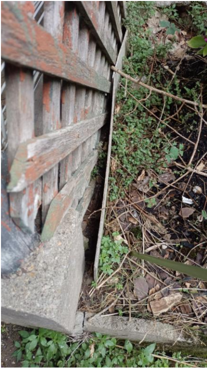
Photo n° PhA002 Localisation : Parties extérieures Ouvrage : Murs et cloisons Partie d'ouvrage : Revêtements durs (plaques planes fibres-ciment) Description : Revêtements durs (plaques planes fibres-ciment)
