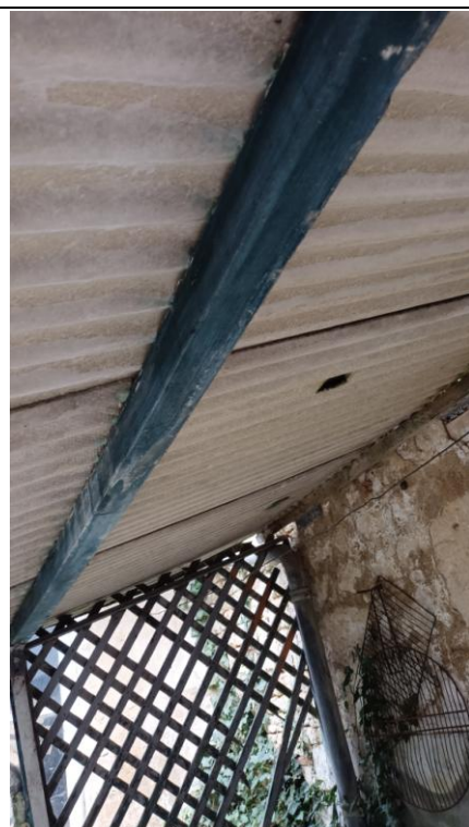
Photo n° PhA001 Localisation : dessus de puits Ouvrage : Plaques ondulées Partie d'ouvrage : Plaques en fibres-ciment Description : Plaques en fibres-ciment
