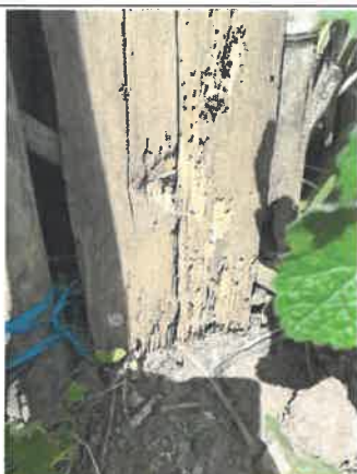
Photo n° PhTer001 Localisation : Extérieur Ouvrage : Jardin Bois poteaux Parasite : Présence d'indices d'infestation de termites Indices : altérations dans le bois, bois d'apparence feuilleté
