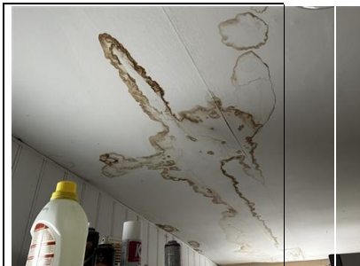
Photo n° PhTer001 Localisation : Rez de chaussée - Cellier Ouvrage : Plafond - Plâtre et/ou Plaques de plâtre et Peinture Informations complémentaires : Présence de traces d'humidité
