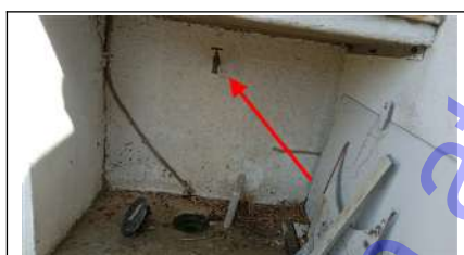
Photo n° PhAss001 Localisation : Eau Usée : Préau 1 Description : Robinet de puisage : Rejet non retrouvé
