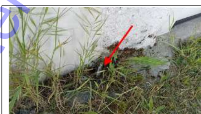
Photo n° PhAss002 Localisation : Eau Usée : Garage 1 Description : Ballon d'eau chaude : Rejet par épandage
