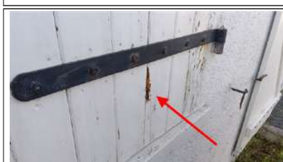
Photo n° PhTer005 Localisation : Rez de chaussée - Chambre 1 Ouvrage : Volets - Bois et Peinture Parasite : --- Champignons lignivores ---
