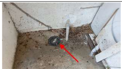
Photo n° PhAss004 Localisation : Eau Pluviales : Extérieur Description : Bonde de sol : Rejet non retrouvé
