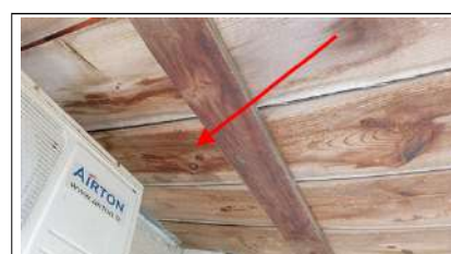
Photo n° PhTer003 Localisation : Bâtiment (s) Annexe (s) - Préau 1 Ouvrage : Plafond - Ossature Métallique et Volige bois Informations complémentaires : Présence d'humidité sur le (s) plafond (s)
