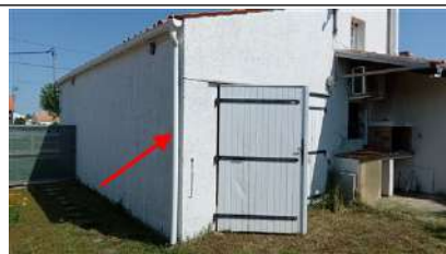
Photo n° PhAss005 Localisation : Eau Pluviales : Extérieur Description : Gouttière arrière/rue (droite) : Rejet non retrouvé
