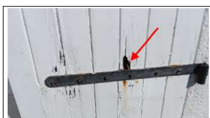
Photo n° PhTer001 Localisation : Rez de chaussée - Chambre 2 Ouvrage : Volets - Bois et Peinture Parasite : --- Champignons lignivores ---
