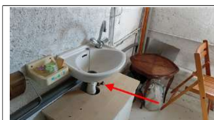
Photo n° PhAss003 Localisation : Eau Usée : Grenier Description : Lavabo : Rejet non retrouvé
