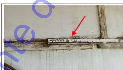
Photo n° PhTer002 Localisation : Bâtiment (s) Annexe (s) - Préau 2 Parasite : --- Champignons lignivores ---
