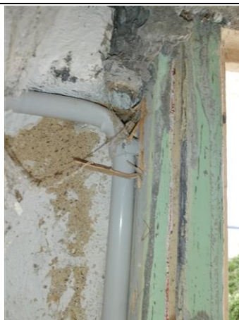
Photo n° PhTer002 Localisation : Sous-Sol - Cave 1 Ouvrage : Huisserie (s) - Bois et Peinture Parasite : Présence d'indices d'infestation de termites Indices : bois d'apparence feuilleté
