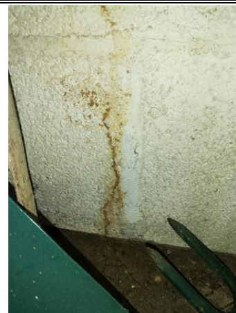
Photo n° PhTer005 Localisation : Bâtiment (s) Annexe (s) - Abri de jardin 2 Ouvrage : Mur - Parpaings Parasite : Présence d'indices d'infestation de termites Indices : présence de cordonnets Informations complémentaires : Présence d'injecteurs sur les murs.
