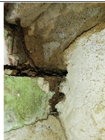
Photo n° PhTer003 Localisation : Bâtiment (s) Annexe (s) - Abri de jardin 1 Ouvrage : Plafond - Charpente : Chevrons, liteaux Bois Parasite : Présence d'indices d'infestation de termites Indices : bois d'apparence feuilleté
