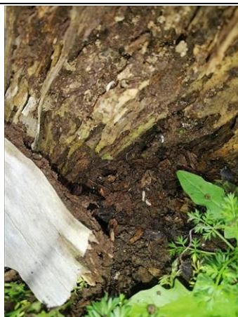
Photo n° PhTer007 Localisation : Bâtiment (s) Annexe (s) - Garage Ouvrage : Mur - Parpaings Parasite : Présence d'indices d'infestation de termites Indices : présence de cordonnets Informations complémentaires : Présence d'injecteurs sur les murs
