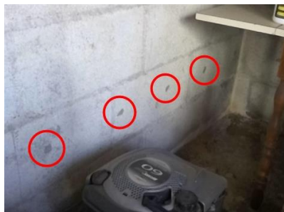
Photo n° PhTer001 Localisation : Bâtiment (s) Annexe (s) - Abri de jardin 2 Ouvrage : Mur - Parpaings Parasite : Présence d'indices d'infestation de termites Indices : présence de cordonnets Informations complémentaires : Présence d'injecteurs sur les murs.
