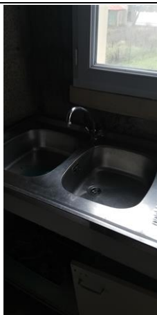
Photo n° PhAss001 Localisation : Eau Usée : Atelier Description : Evier : Rejet dans les eaux pluviales
