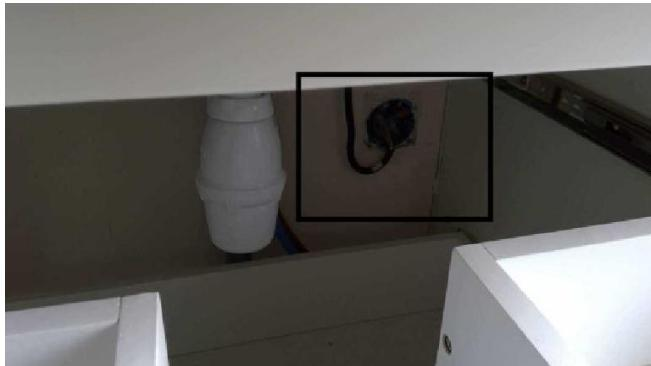
B.7.3 d) : L'installation électrique comporte au moins une connexion avec une partie active nue sous tension accessible.
